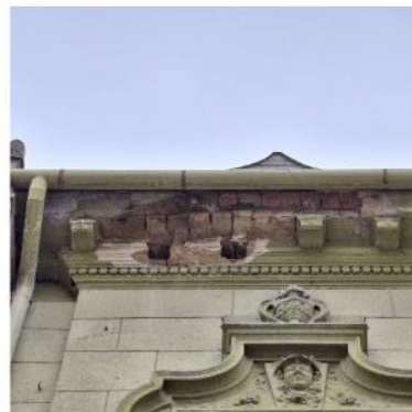
Koronázó párkányt alátámasztó díszített gipsz konzol hiányzó elemei, pótolni szükséges
