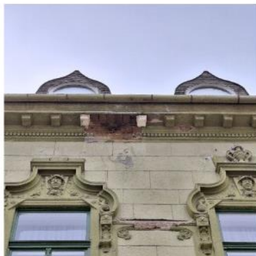
Koronázó párkányt alátámasztó díszített gipsz konzol hiányzó elemei, pótolni szükséges
