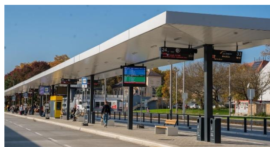
72. ábra A kaposvári helyközi buszállomás, ahol a vasúttal közös kijelzők is megjelennek
