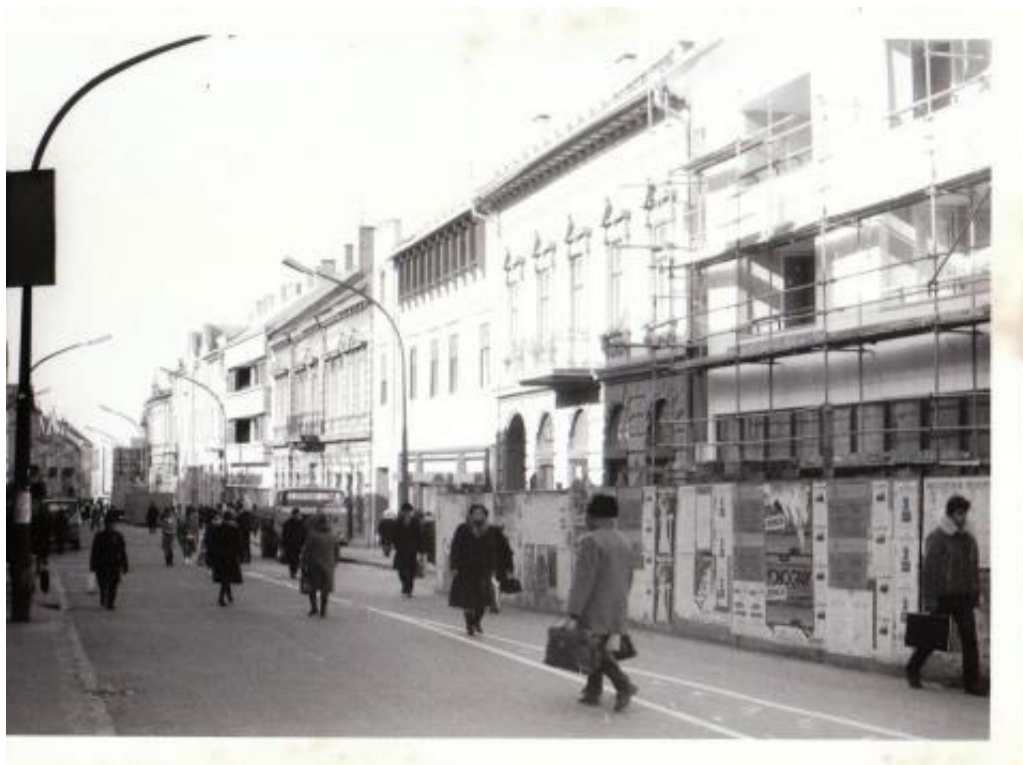
27. Fő utca (a sétálóutca építése)
