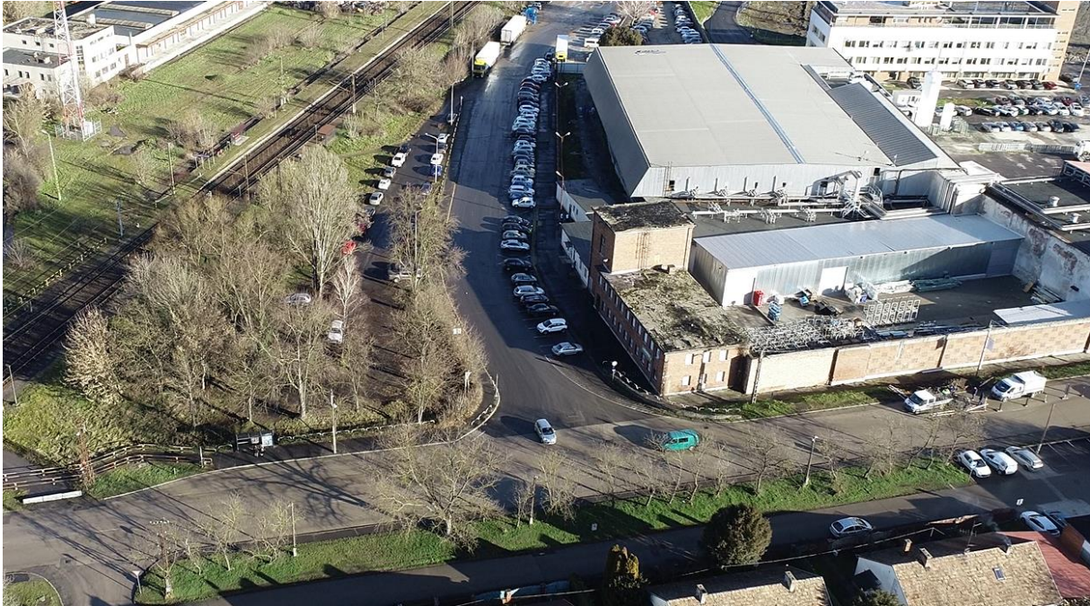
Szennyvíztelepi út Pécsi utcai kicsatlakozása (drónfelvétel)
